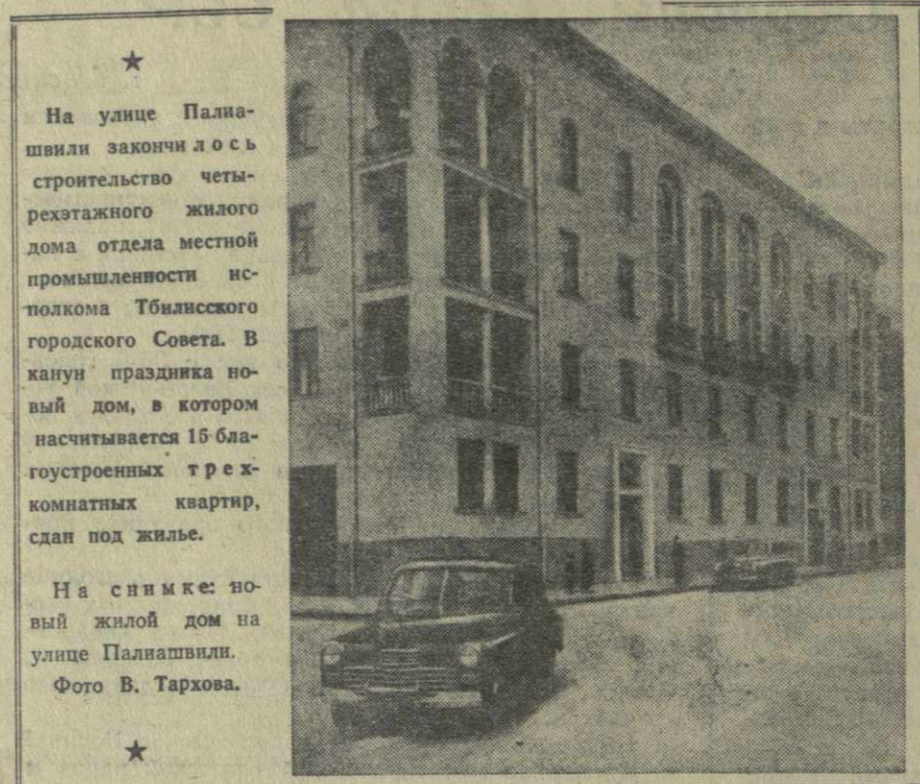
На улице Палиашвили закончили строительство четырехэтажного жилого дома отдела местной промышленности и Тбилисского городского Совета. В канун праздника новый дом, в котором насчитывается 15 благоустроенных трехкомнатных квартир, сдан под жилье.
