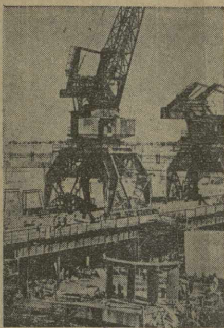
Новая Каховка. Строителя Каховского гидроузла приступили к монтажу первой турбины гидроэлектростанции.
