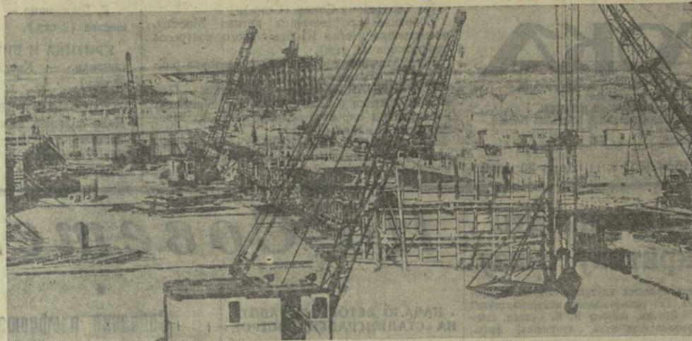
Каховский гидроузел. На строительстве судокорпуса плотины начались установка арматуры и укладка бетона во второй ярус плотины. Покрытым ходом идет сооружение здания ГЭС и водосливной плотины. Укладывается бетон, устанавливается арматура на левобережной площадке здания ГЭС.
