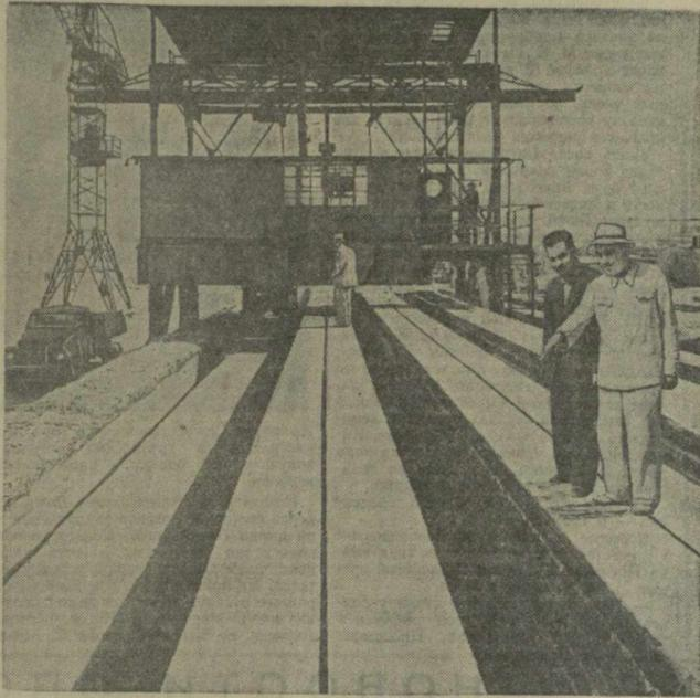
Машина настывает бетон длинными полосами, сама разравнивает и трамбуется. Специальная механизированная пила режет бетонные полосы на плиты нужных размеров.
