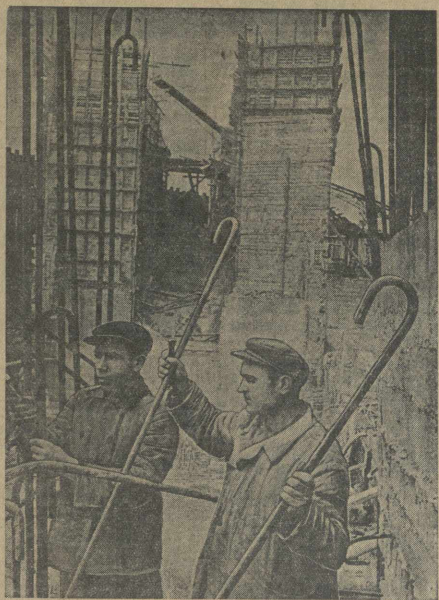
На строительстве Орчальской гидроэлектростанции. На снимке (слева направо): участники стахановской вахты в честь сессии Верховного Совета СССР бригады арматурщиков А. Меркулов и арматурщик Н. Кобулашвили.
