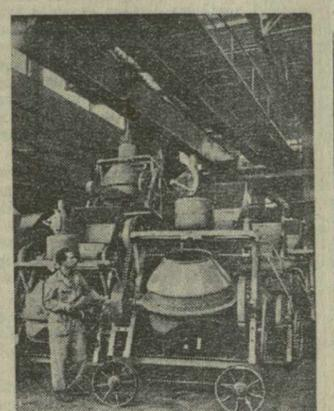
Сталинская область. Славянский завод строительных машин успешно выполняет заказы сельского хозяйства. Сейчас предприятие выпускает бетономешалки емкостью 250 литров. Первые 50 машин изготовлены досрочно.
