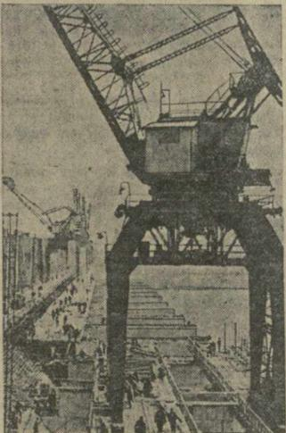
Волгодонстрой. Закончив бетонирование быков нижнего бьефа водосливной железобетонной плотины Цимлянского гидроузла, строители приступили к переносу эстакады на ее постоянное место, не разбирая порталных кранов.
