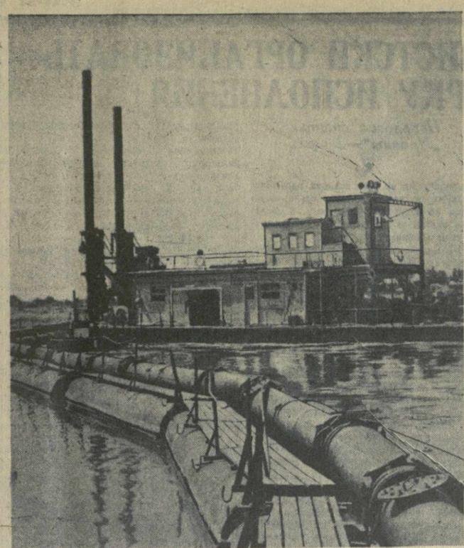
Сталинградгидрострой. На сооружении канала, который соединит Волгу с Ахтугой, гидромеханизаторы вынули уже сотни тысяч кубометров грунта. На снимке: земснаряд № 322 на сооружении канала Волга—Ахтуба. Фото А. Маклецова (Фотохроника ТАСС)
