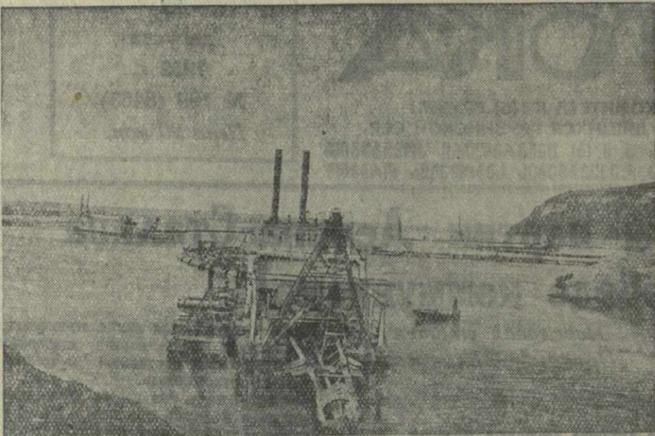
Куйбышевгидрострой. В русловой части гигантского котлована под здание гидроэлектростанции работают четыре сверхмощных землесосных снаряда типа «Сталинградский-1000-80».
