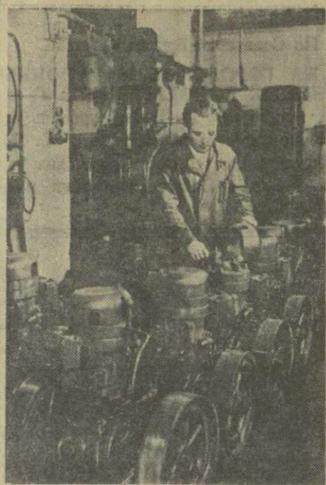
Латвийская ССР. Райский машиностроительный завод «Мискомандель» выпускает двигатели внутреннего сгорания «МД-9» для механизации трудовых процессов в сельском хозяйстве. Они используются для водных насосов, на кормоуборочных и др. На снимке: мастер сборочного цеха Р. Юмиекс за проверкой качества сборки двигателя «МД-9». Фото Е. Ясенова. Фотохроника ТАСС.
