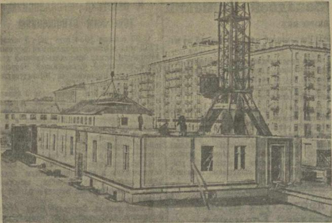
На 6-й улице Октябрьского поля сооружается первый в Москве бескаркасный крупнопанельный жилой дом. Дом полностью собирают из изготовляемых на заводе крупных железобетонных деталей. Затраты труда при сооружении такого дома уменьшаются в три-четыре раза по сравнению со строительством кирпичного здания. На снимке: монтаж первого этажа крупнопанельного дома на 6-й улице Октябрьского поля. Фото В. Акимова. Фотохроника ТАСС.
