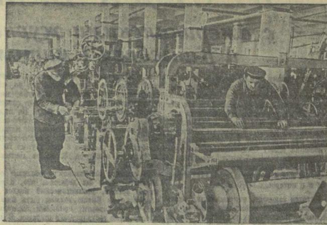
Эстонская ССР. В ткацком цехе Новоткацкой фабрики комбината «Кренгольмская мануфактура» заканчивается монтаж нового оборудования. Здесь устанавливаются широкие автоматические ткацкие станки новейшей конструкции. Всего на предприятии до конца года будет установлено 917 таких станков. На с. и м. к.: в новом ткацком цехе. Рабочие К. Рейнол (слева) и П. Григорьев (справа) наладывают автоматические ткацкие станки. Фото В. Самусенко. Фотохроника ТАСС.
