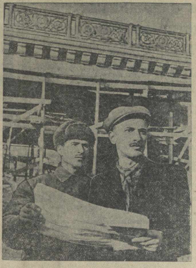
На строительстве моста имени Эбзакидзе в Тбилиси. На снимке: прораб Г. Квичидзе дает задание бригадире плотников П. Василенко.
