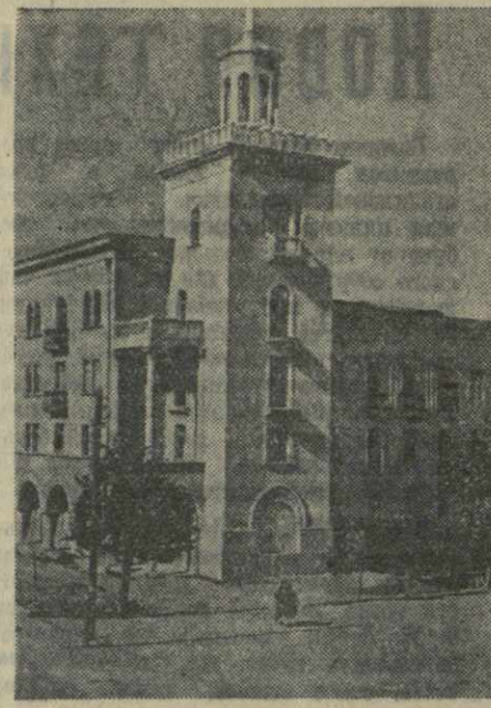
Телав. На центральной улице имени Ленина закончено строительство нового четырехэтажного жилого дома для рабочих и служащих шелкоткальной фабрики. На снимке: новый жилой дом шелкоткальной фабрики.
