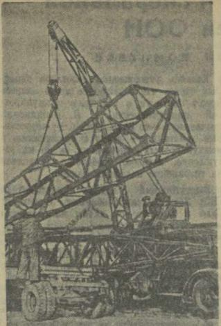
Завод треста «Грузгидроэнергострой» изготовляет металлические опоры для линий электропередачи. На снимке: отгрузка металлических опор на один из строительных участков.
