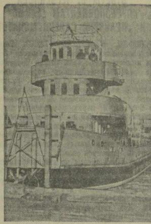
Украинская ССР. Коллектив Херсонского судостроительного завода имени Коминтерна освоил новый вид судов, буксирных барж методом толкания. Строится озерный буксир-толкатель мощностью в 300 лошадиных сил. Он успешно прошел заводские испытания. В нынешнем году предприятие начнет серийный выпуск судов такого типа. Первый буксир-толкатель построен для Днепровского пароходства и будет осуществлять буксировку барж в Каховском море.
