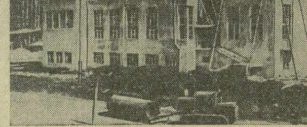
На строительстве Батумского нефтеперерабатывающего завода имени И. В. Сталина. Завод вошел в строй действующих предприятий в первой пятилетке.
