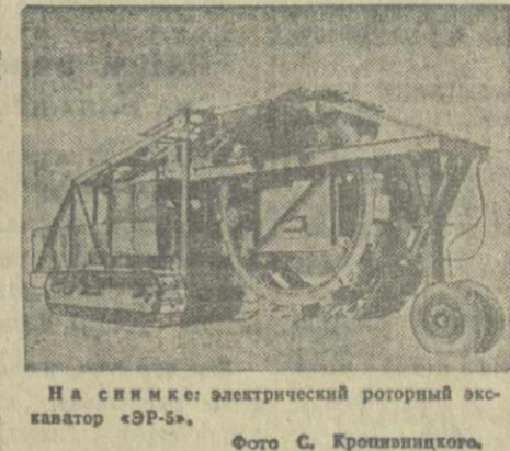
На снимке: электрический роторный экскаватор «ЭР-5». Фото С. Кропачкина.
