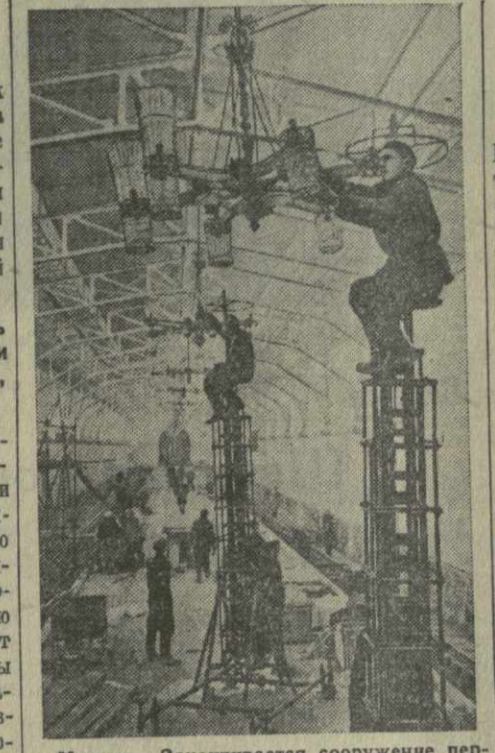
Москва. Заканчивается сооружение первой наземной станции метро «Перваямайская». Эта станция расположена в Измайловском районе и будет соединена наземным и подземным путями с действующей линией метро. Сейчас здесь ведутся последние отделочные работы. На снимке: монтаж люстр на перроне новой станции. Фото М. Харлампиева. Фотохроника ТАСС.
