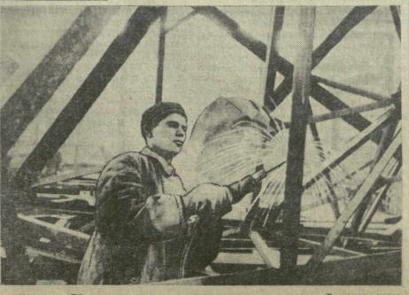
Коллектив Тбилисского ремонтно-механического завода треста «Грузгидроэнергострой» успешно выполняет заказы энергостроек республики. На с н и м к е: передовой электросварщик завода В. Зайдев за сваркой секций опор линии передачи для строительства Храмгэс-2. Фото М. Квирикашвили,
