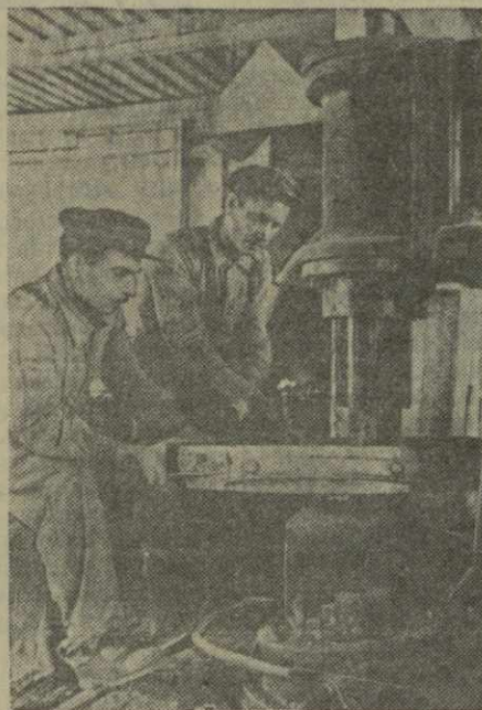
Механизаторы Цительской МТС ремонтируют тракторы передовым узловым методом. На снимках: 1. Кузнечный цех. В. Гоголашвили (слева) и К. Багров в пневматическом молоте. 2. Слесарно-сборочный цех. С. Арзуманян (слева) и Г. Мегребанов собирают задний мост трактора. 3. Токарный цех. Зав. мастерскими Н. Вербовский (в центре) проводит работу токаря В. Кунчина.
