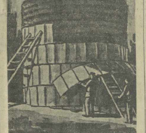
После осадки силосной массы разборную башню снимают для повторного использования, а силос хранится в «бесстенной» башне.
