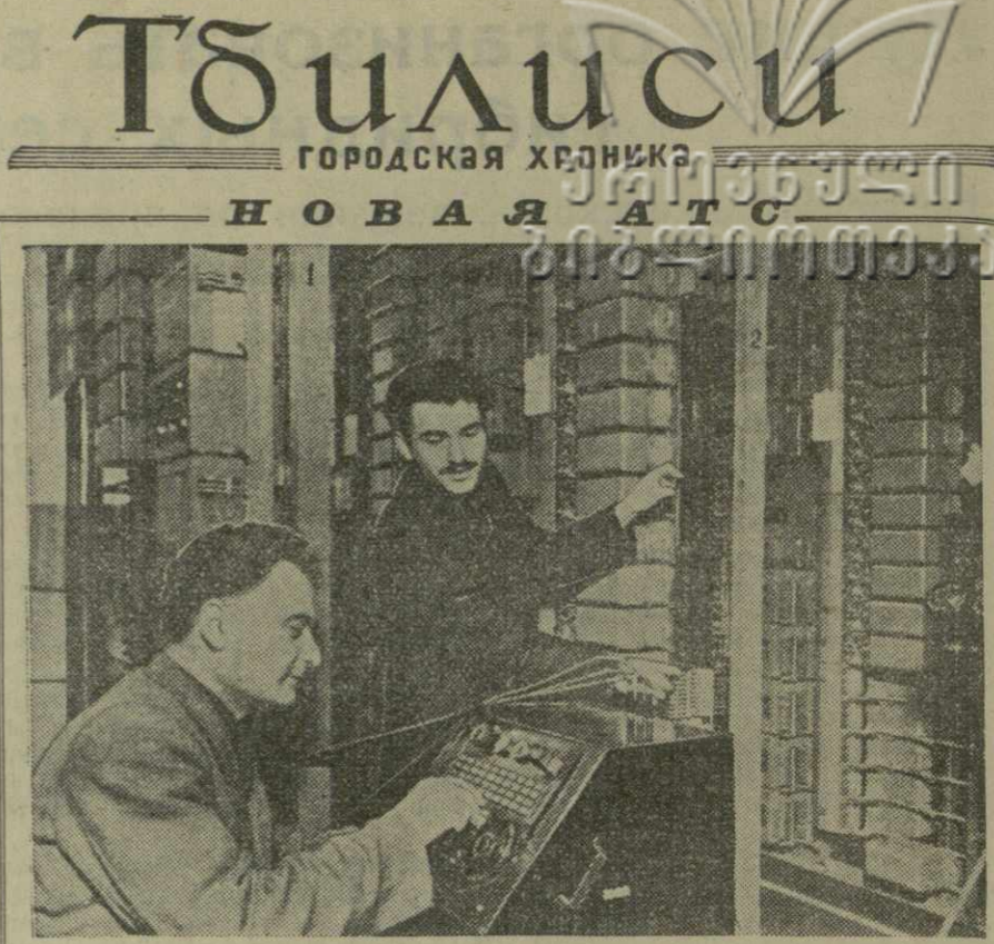
В Сабуртало (район имени Орджоникидзе) закончен монтаж новой автоматической телефонной станции. Она рассчитана на 600 номеров. Станция будет обслуживать население, учреждения и предприятия, расположенные на территории от площади Героев Советского Союза до Медицинского городка и кирпичного завода. Набор номеров телефонов этой АТС будет производиться через цифру 2. На снимке (слева направо): главный инженер Тбилисской городской телефонной сети С. Твардзе и старший механик-техник Н. Джиния проводят испытание новой АТС перед пуском. Фото В. Черкасова.
