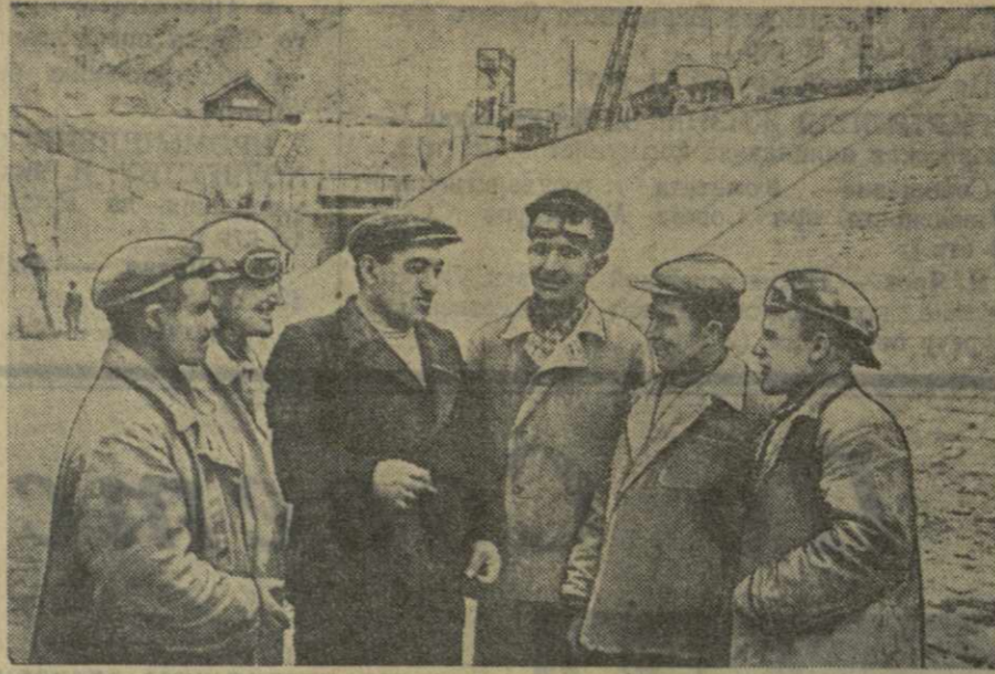
В Азербайджанской ССР заканчивается строительство Верхне-Карабахского оросительного канала, сооружаемого на базе Мингечурского водохранилища. Его длина — 170 километров. Канал пройдет по Ширванскому, Карабахскому и Муганским степям республики и орошит 40 тысяч гектаров земель. На снимке вверху — передовые строители канала (слева направо) — машинисты Б. Агаев, А. Умулов, начальник 1-го участка тоннельных работ А. Григорян, строитель Г. Захарян, облицовщик А. Мусаев и машинист И. Ломакян. Фото Ф. Шецовца. Фотокроника ТАСС.
