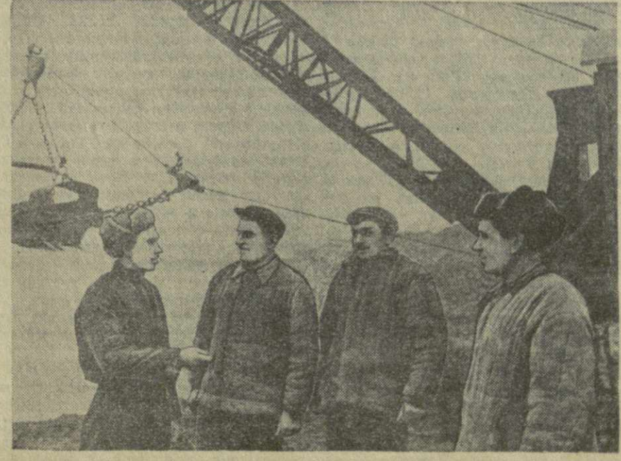
Тбилиси. На строительстве подпорной стены набережной. На снимке: передовые рабочие (слева направо): бригадир плотников Ф. Каданцев, бригадир бетонщиков Г. Мведлишвили, бетонщик П. Модрегадзе и слесарь-механик В. Денисов. Фото В. Тархова.
