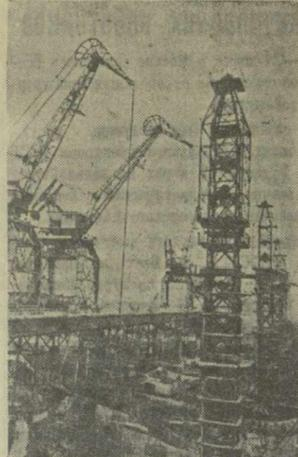
На строительстве Куйбышевской гидроэлектростанции устанавливаются телескопические краны высотой 67 метров с вылетом стрелы на 40 метров для монтажа гидротурбин и гидрогенераторов.
