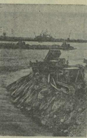
Строители Каховского гидроузла перекрывают основное русло Днепра большой земляной плотиной. Вся перекрытая ширина русла составляет 900 метров. На этом этапе Днепр будет окончательно перекрыт, и воды его пойдут через бетонную водосливную плотину.
