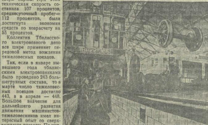
В этом огромном, залитом светом зале с тщательно убраным, без соринки полом ремонтируются и осматриваются электровозы. Вдоль всего помещения протянулись ремонтные каналы, облицованные белоснежным кафелем. Над одной из них, как это видно на нашем снимке, сейчас установлен для ремонта электровоз «ВЛ22-м-366».
