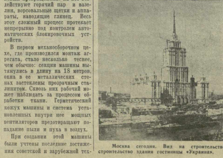
Москва сегодня. Вид на строительство Ново-Арбатского моста через Москву-реку и строительство здания гостиницы «Украина». Фото Н. Грановского. Фотохроника ТАСС.
