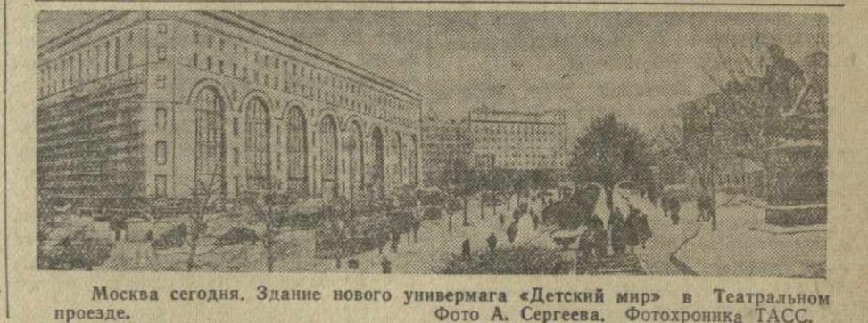
Москва сегодня. Здание нового универмага «Детский мир» в Театральном проезде. Фото А. Сергеева. Фотохроника ТАСС.
