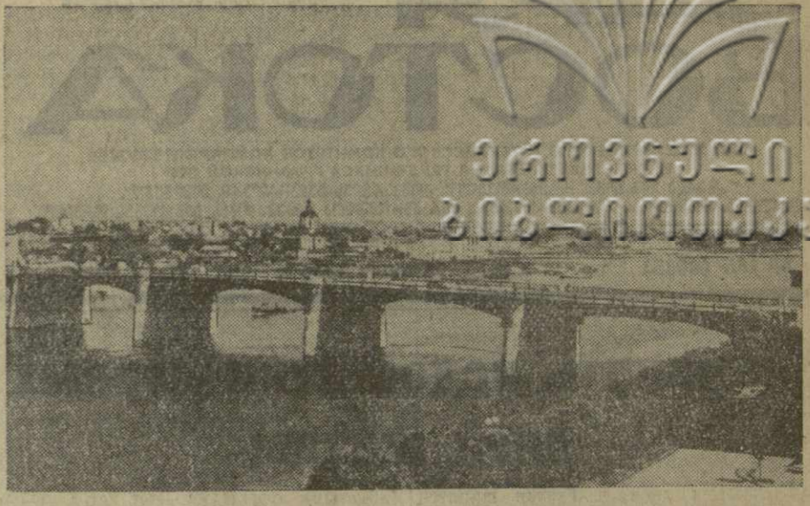
В Калинин строится мост через Волгу. Он свяжет левобережный промыш- ленный район с центром города. На снимке: строительство моста через Волгу. Фото Н. Чамова. Фотохроника ТАСС.
