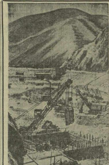
Восточно-Казахстанская область. Строители Бухтарминской ГЭС наращивают темпы укладки бетона в водосливную часть плотины гидроузла. Завершено бетонирование первых двух блоков. Начата укладка бетона в третий блок. По объекту на значительно больше предумышленных, вместе взятых.
