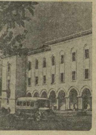
В Кобулету заканчивается строительство нового административного дома. На снимке: новый дом. Фото В. Тархова.
