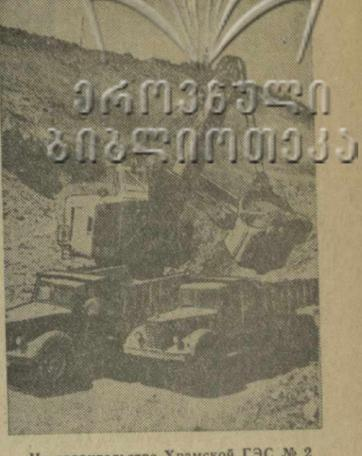
На строительстве Храмовской ГЭС № 2 земляные работы выполняются с помощью мощных экскаваторов и автосамосвалов. На снимке: погрузка 10-тонного автосамосвала.
