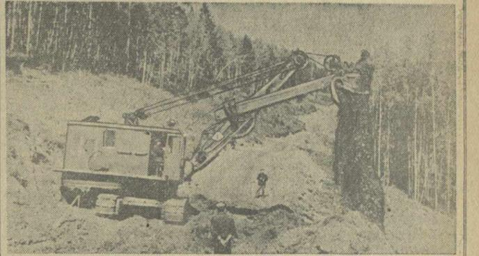
Строители Красноярской ГЭС прокладывают трассу будущего бетонированного шоссе Красноярск — Шумиха. На строительстве применяются мощные бульдозеры и экскаваторы, работают бульдозерные автомобиль-самосвалы.
