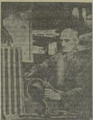
Слесарь сборочного цеха Тбилисского авторемонтного завода Б. Сидомонидзе, участвуя в соревновании в честь XX съезда КПСС, выполняет задание на 250—300 процентов. На снимке: Б. Сидомонидзе за креплением крыла машины ГАЗ-51.
