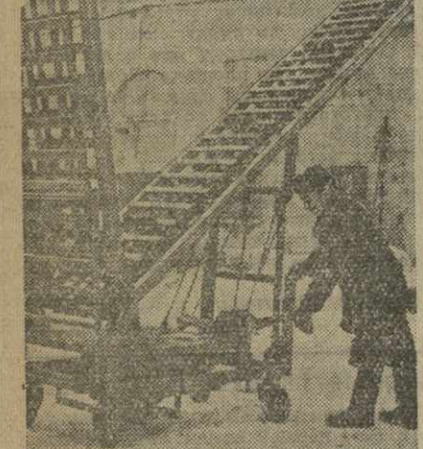
Свердловск. Завод торгового машиностроения изготовил наклонный транспортер для переноски и погрузки тяжестей. За один час он может поднять и переместить свыше тридцати тонн груза.
