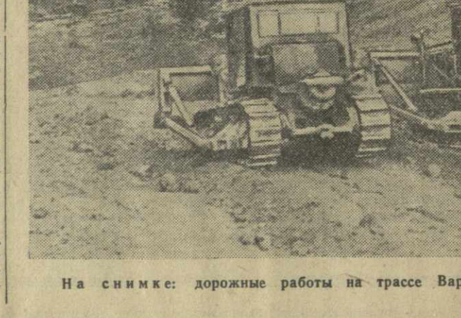
На снимке: дорожные работы на трассе Варзихевской улицы. Фото В. Тархова.
