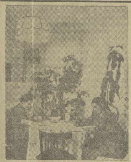
Горький. Замечательную инициативу проявил автозаводчик. Своими руками они начали строительство жилищ. Строительные бригады сооружают дома в свободное от работы время.
