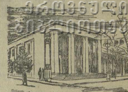
В Душети закончили строительство нового районного Дома культуры, который имеет зрительный зал на 400 мест...
