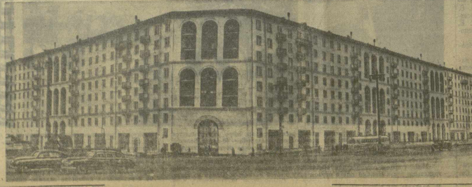
Корпус № 9 в тринадцатом квартале Юго-Западного района Москвы, сооруженный коллективом треста «Мосстрой» № 3. Здесь москвичи получили более 600 квартир общей жилой площадью около 26 тысяч квадратных метров. В пяти корпусах этого облицованного светлой керамикой девятиэтажного здания все квартиры оборудованы центральным отоплением, газом, телефоном, горячим водоснабжением. Красив и благоустроен внутренний двор нового дома.
