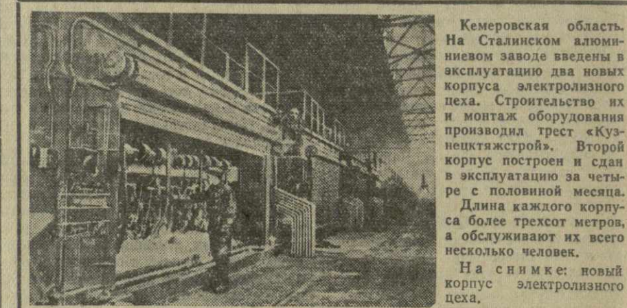
Кемеровская область. На Сталинском алюминиевом заводе введены в эксплуатацию два новых корпуса электролизного цеха. Строительные и монтаж оборудования производил трест «Кузнецкстрой». Второй корпус построен и сдан в эксплуатацию за четыре с половиной месяца.
