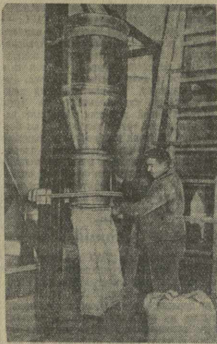
Готовый комбикорм высыпается из выбойного аппарата в мешок. Фото В. Тархова.
