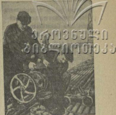
Станиславская область. На Долинском нефтепромысле сданы в эксплуатацию две новые скважины, названные фестивальными. На одной из них — скважина № 118 — на глубине 2.500 метров вскрыт новый нефтеносный пласт. Суточный дебит скважины — 160 тонн жидкого топлива. А с ним к: оператор подземного ремонта И. В. Сичка (слева) и помощник оператора В. Ю. Чиган монтируют арматуру на скважине № 118. Фото С. Полякова. Фотохроника ТАСС.
