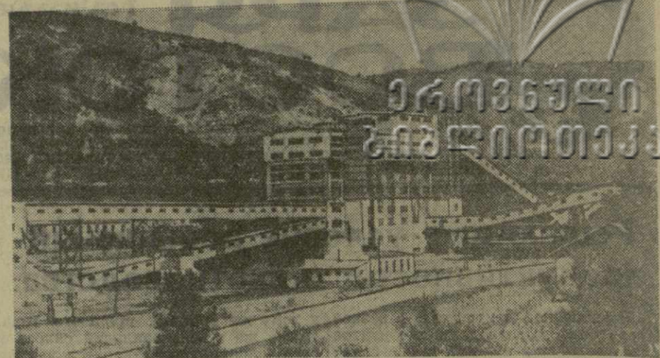
Ежедневно длинными эшелонами из Ткибули отправляются коксующийся уголь для доменных печей Закавказского металлургического завода имени И. В. Сталина. Предварительно уголь обогащается на Ткибульской центральной обогатительной фабрике. На снимке: центральная обогатительная фабрика в Ткибули. Фото П. Луценко. (Фотохроника ГрузТАГА).
