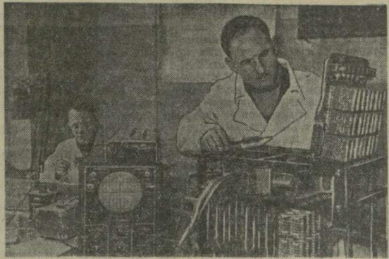
На снимке: на переднем плане — инженер Тбилисского научно-исследовательского института приборостроения и средств автоматизации Г. Отарашвили за наладкой специализированной математической машины, управляющей процессом загрузки доменных печей. Фото В. Тархова.
