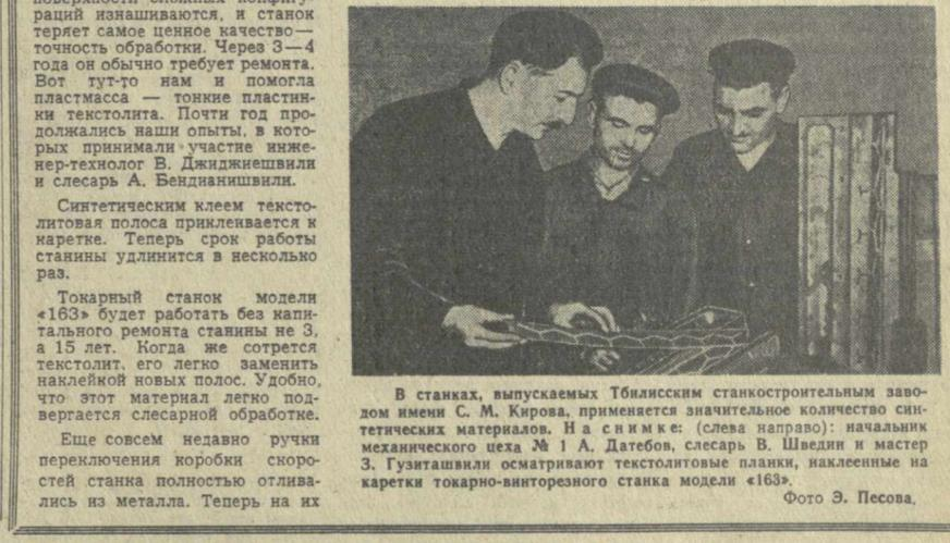
В станках, выпускаемых Тбилисским станкостроительным заводом имени С. М. Кирова, применяется значительное количество синтетических материалов. А в снимке: (слева направо): начальник механического цеха № 1 А. Датеб, слесарь В. Швеида и мастер З. Гушташвили осматривают текстолитовые планки, наклеенные на каретку токарно-винторезного станка модели «163».
