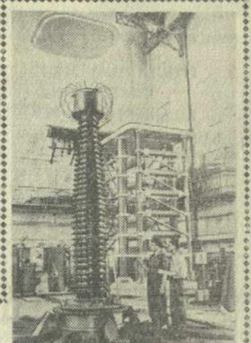
Производственный завод «Изавет» закончил сборку двух высоковольтных высоковольтных вводов на напряжение 500.000 вольт. Высоковольтные вводы, созданные заводскими конструкторами и опытными мастерами-производственниками, предназначены — один для Свердловской ГЭС, другой — для подстанции «Южная» (Москва).
