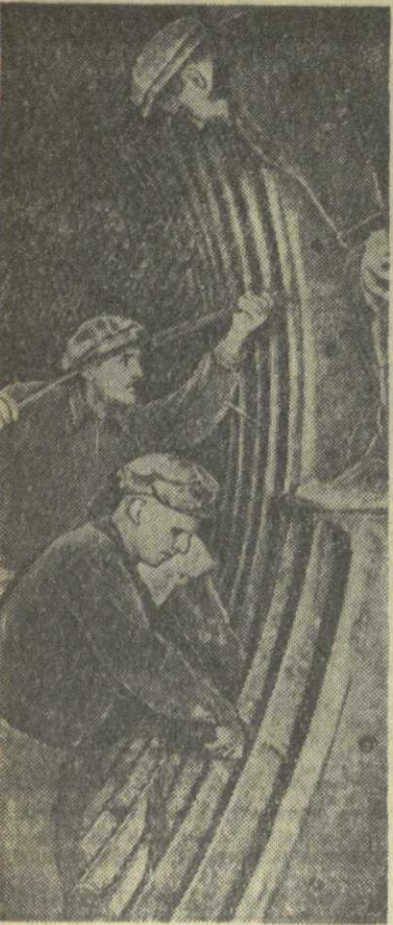
Систематически перевыполняют смежные задания передовые рабочие строительства Ладжанури ГЭС Н. Фелосев, Д. Элбакидзе и др. На снимке: прораб Н. Лендей и рабочие Н. Фелосев и Д. Элбакидзе за перекладкой тубов в тоннельном участке строительства Ладжанурской гидроэлектростанции.
