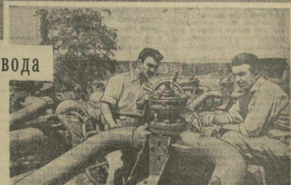
На стройку газопровода прибываю мощные газовые краны. На снимке: главный инженер дирекции газопровода Г. Янковский (справа) и инженер дирекции Н. Давитулани за осмотром оборудования.
