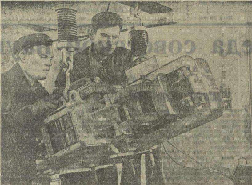
Коллектив сталинградского завода «Электровибромашина» освоил производство и приступил к выпуску новых электровибромашин мощностью в 500 ватт. Эти машины найдут широкое применение в горнорудной и металлургической промышленности для автоматизации целого ряда производственных процессов. На снимке: слесари механического цеха И. Казимиров (слева) и М. Подлесный за сборкой электровибромашин. Фото В. Убоженко. (Фотохроника ГрузТАГа).
